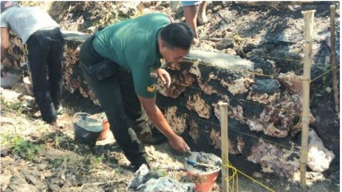
Babinsa Koramil 0829-12/Modung saat membantu pemasangan batu pembuatan irigasi
